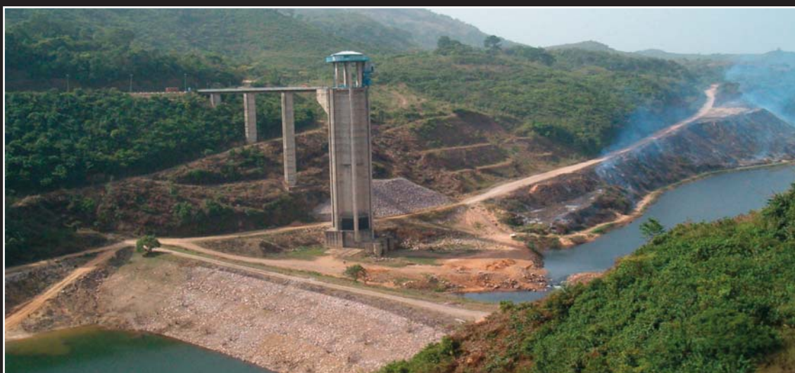
Bumbuna Dam - Сьерра-Леоне
